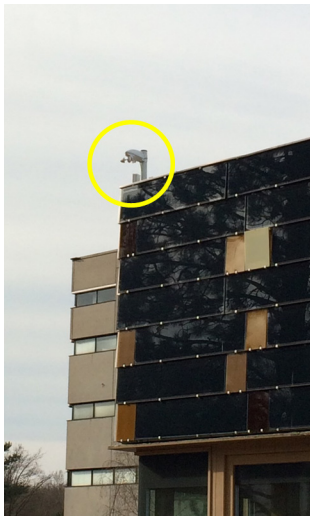
Abb. 3.49: Wetterstation (links) und Präsenzmelder (rechts) mit KNX-Schnittstellen am SurPLUShome
