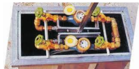
Doppelzähler-Anlage
