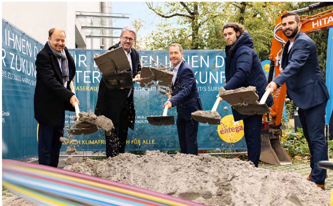
Spatenstich für die Erschließung des Darmstädter Edelsteinviertels: Thomas Schmidt, ENTEKA AG, Patrick Burghardt, Staatssekretär im Hessischen Digitalministerium, Michael Kolmer, Stadtplanungsdezernent Darmstadt, Stefan Backmund, bauverein AG, und Jan Simons, Bundesverband Breitbandkommunikation e. V. (BREKO) (v. l. n. r.)
