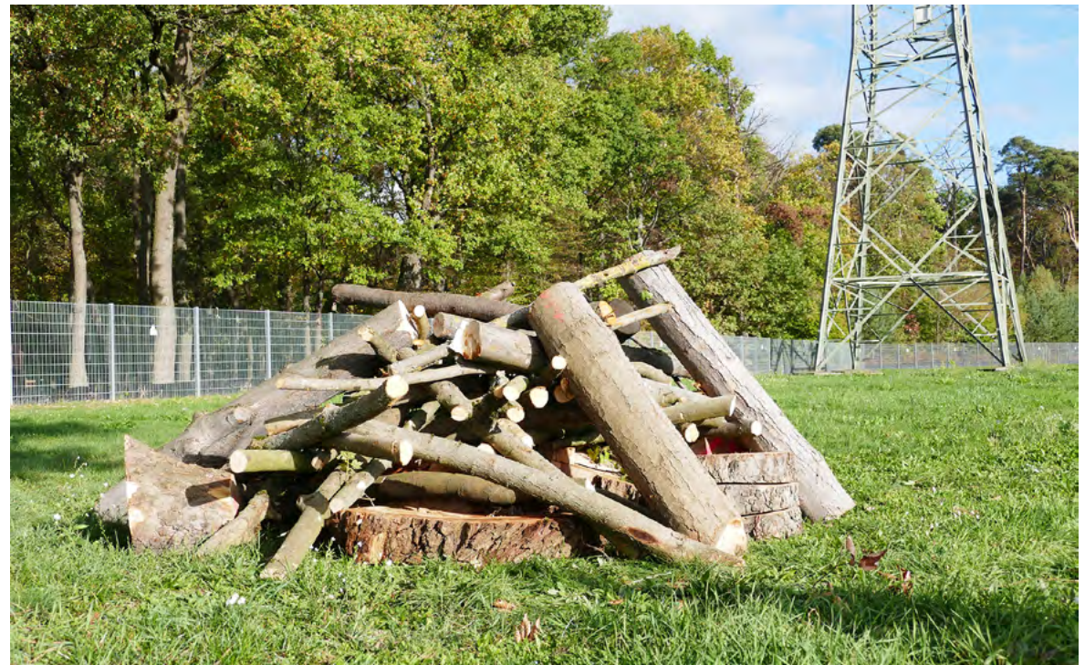
Biodiversitätsmaßnahmen am Umspannwerk Leonhardstanne
