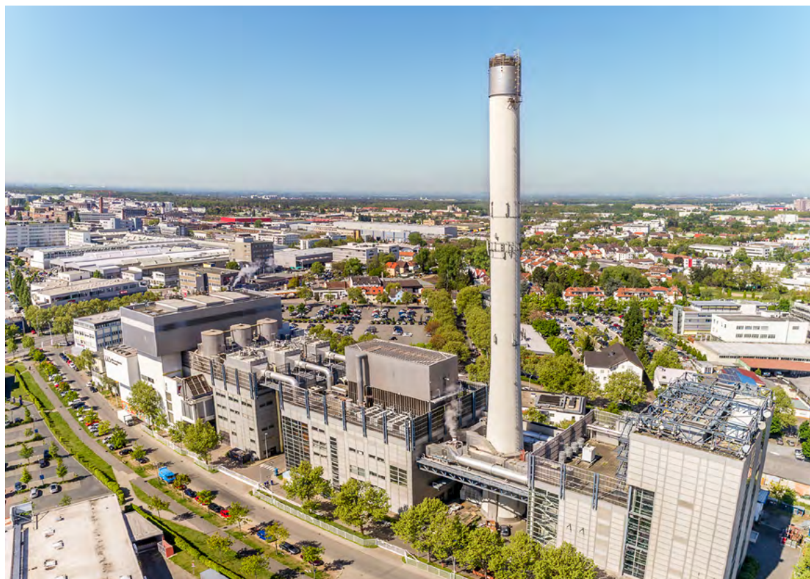
Das Darmstädter Müllheizkraftwerk erzeugt klimaschonend Wärme
