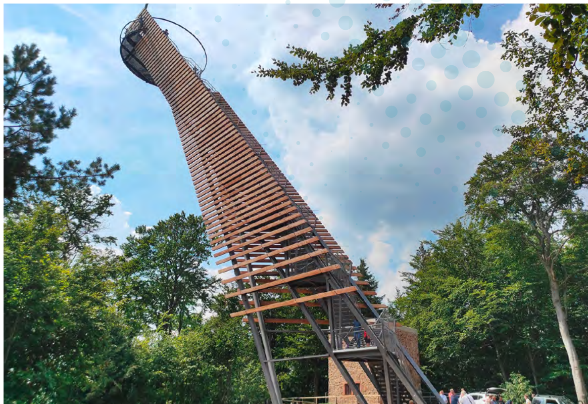
Die Funknetzinfrastruktur stützt sich auf 12 Funkstandorte. In Rimbach (Odenwald) sind Funkantenne und Technik beispielsweise im höchsten Ort des Landkreises Bergstraße beherbergt, dem etwa 34 Meter hohen Trommturm.
