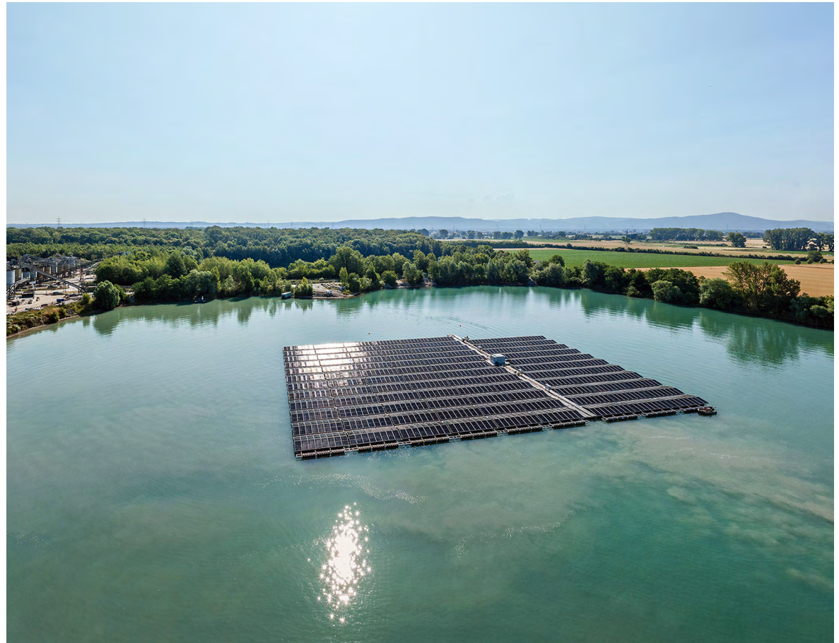
Schwimmende Solaranlage in Riedstadt – eine innovative Lösung
