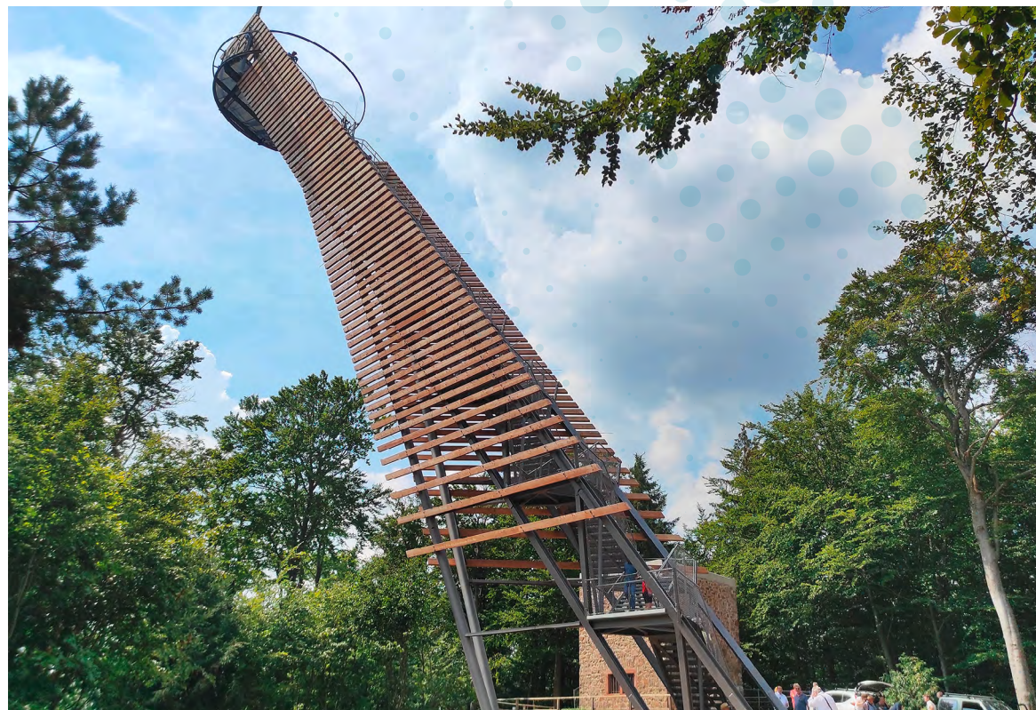
Die Funknetzinfrastruktur stützt sich auf 12 Funkstandorte. In Rimbach (Odenwald) sind Funkantenne und Technik beispielsweise im höchsten Ort des Landkreises Bergstraße beherbergt, dem etwa 34 Meter hohen Trommturm.
