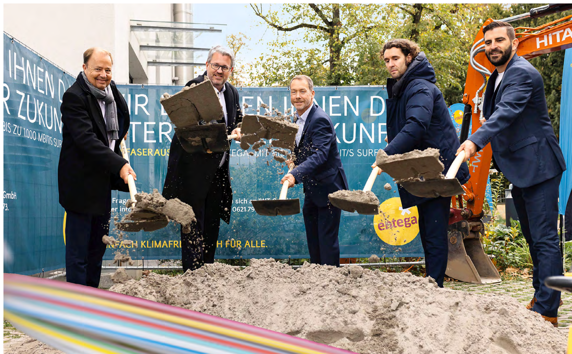
Spatenstich für die Erschließung des Darmstädter Edelsteinviertels: Thomas Schmidt, ENTEGA AG, Patrick Burghardt, Staatssekretär im Hessischen Digitalministerium, Michael Kolmer, Stadtplanungsdezernent Darmstadt, Stefan Backmund, bauverein AG, und Jan Simons, Bundesverband Breitbandkommunikation e. V. (BREKO) (v. l. n. r.)
