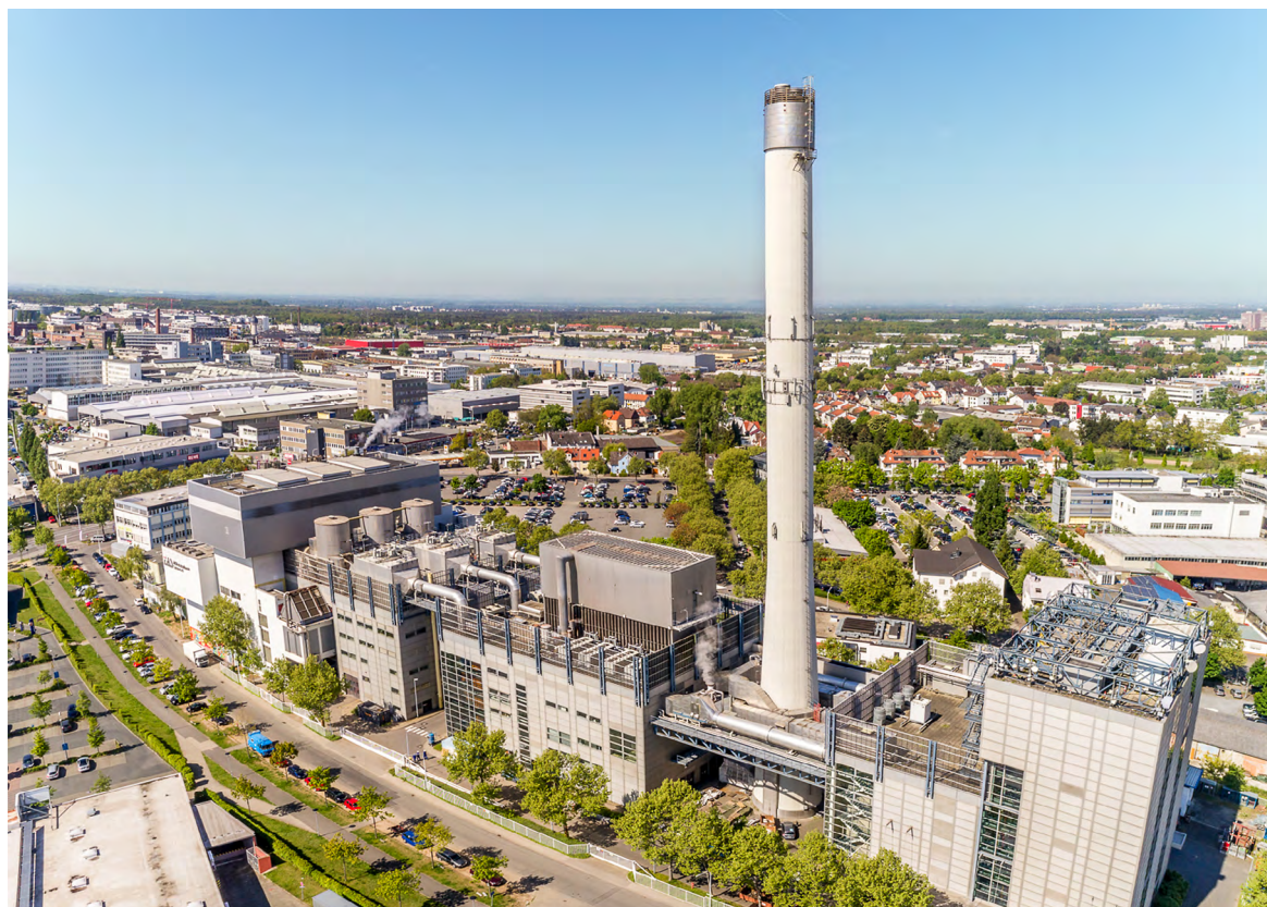
Das Darmstädter Müllheizkraftwerk erzeugt klimaschonend Wärme
