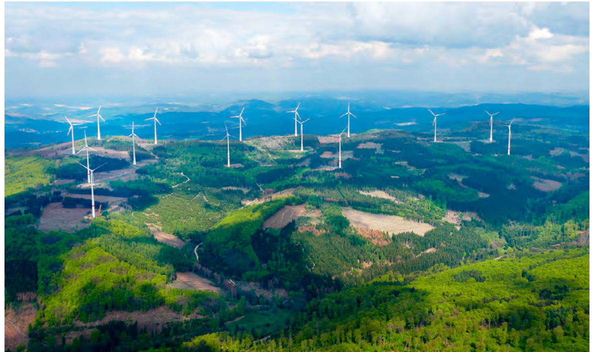
Der fertige Windpark Hausfirste II direkt neben dem bestehenden Windpark Hausfirste I. Zusammen stehen dort nun 15 WEA
