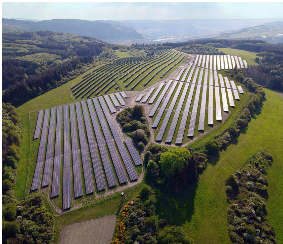
Der Solarpark Leiwen wird erweitert
