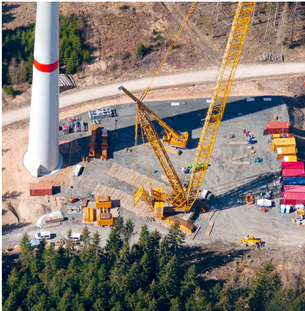
Der Aufbau einer WEA ist echte Präzisionsarbeit
