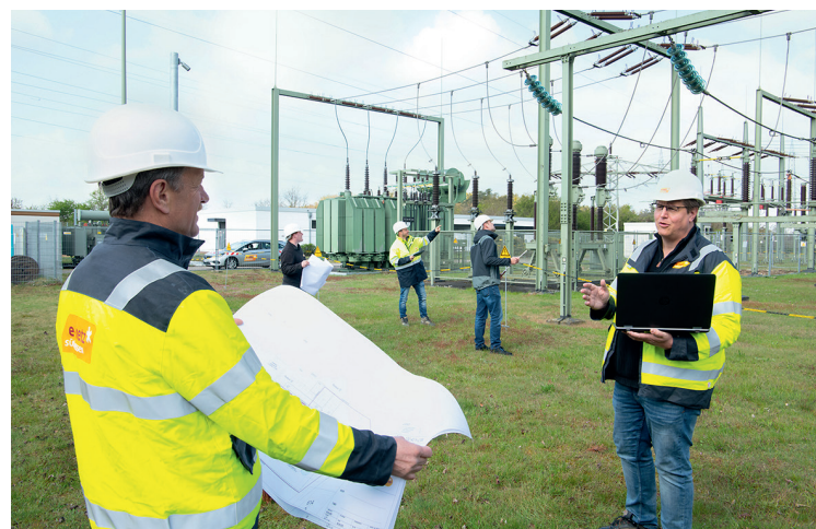
Unsere Stromnetze zählen zu den zuverlässigsten Netzen in Deutschland
