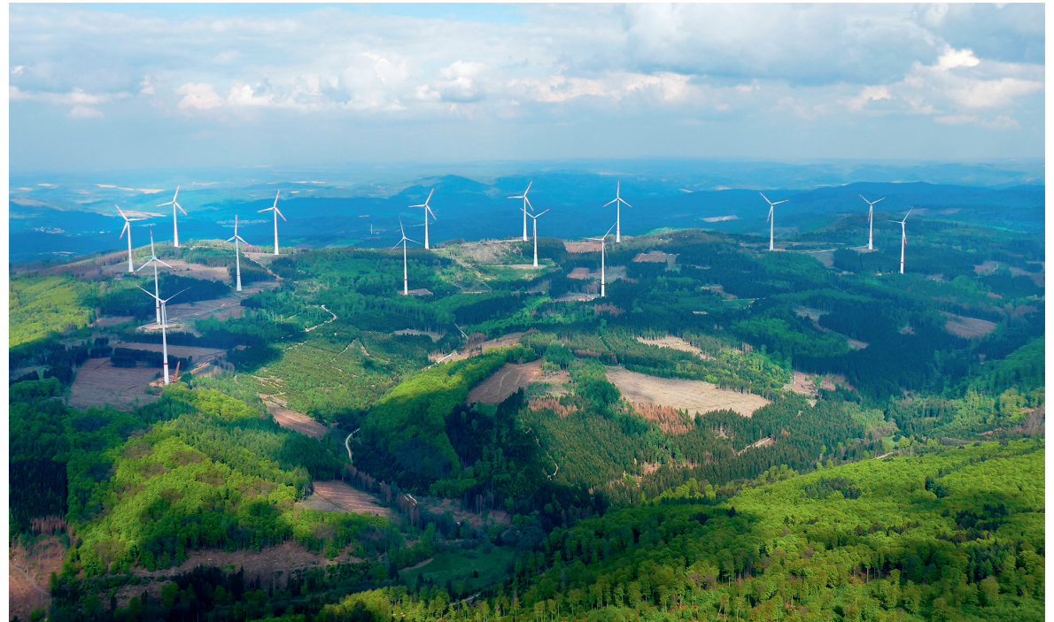
Der fertige Windpark Hausfirste II direkt neben dem bestehenden Windpark Hausfirste I. Zusammen stehen dort nun 15 WEA
