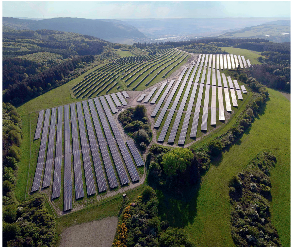
Der Solarpark Leiwen wird erweitert
