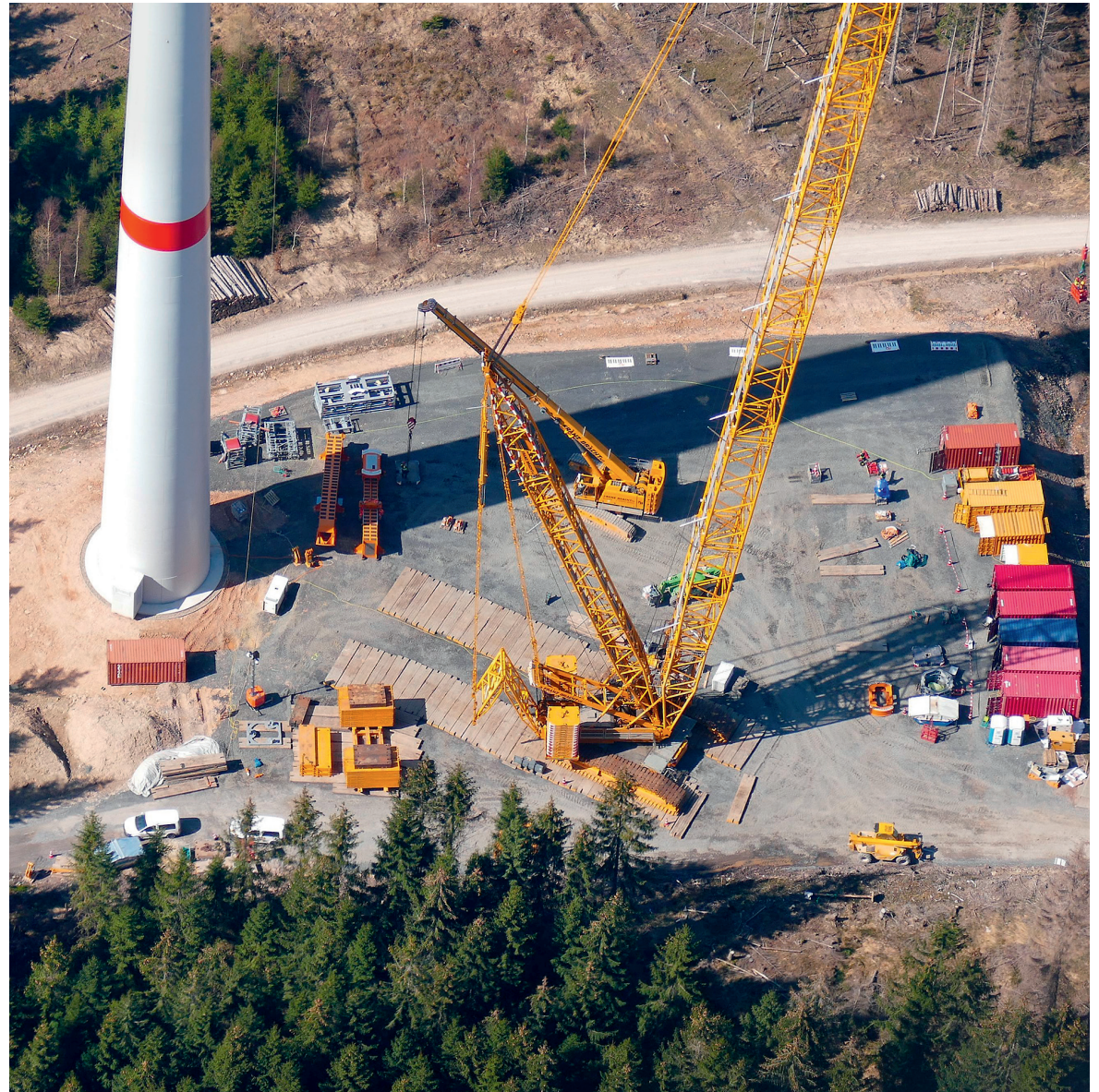
Der Aufbau einer WEA ist echte Präzisionsarbeit
